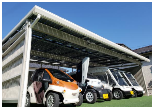
写真1：青空コンセント
