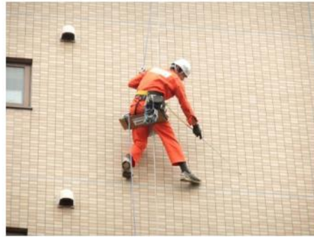
ゴンドラによる外部足場未設置の場合の打診検査
