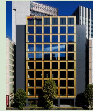
都心の木質サステナブルオフィス 野村不動産溜池山王ビル
