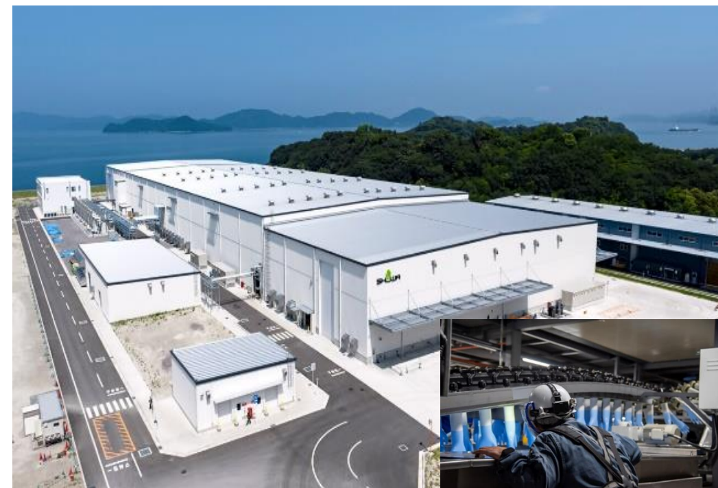
番の州臨海工業団地 ニトリルゴム手袋製造工場
