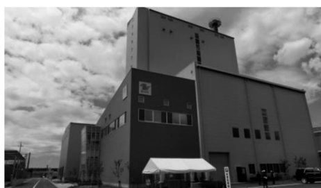
↑ 木質バイオマス発電所
